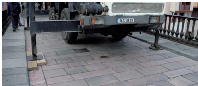
Une chaussée est rarement uniquement piétonne (intervention de camions de livraison, utilitaires, engins de nettoyage etc.). Ces facteurs ont pour effets de creuser les joints souples et fragilisent l'ouvrage allant jusqu'au déchaussement des éléments modulaires.
