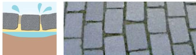
Infiltrations d'eau par les joints qui créent des vides entre et sous les éléments modulaires.
