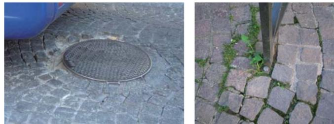
Réalisée sur lits de sable, la chaussée comporte néanmoins des points rigides (cadres, tampons de voirie, bouches à clé). Ces différents matériaux se comportent de façon différente en fonction des contraintes mécaniques et atmosphériques.
