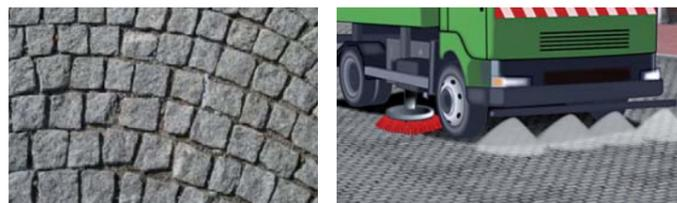
Même fichés, les joints sable se creusent du fait des nettoyages répétés (brosses, jets haute pression, camions de nettoyage etc.).
