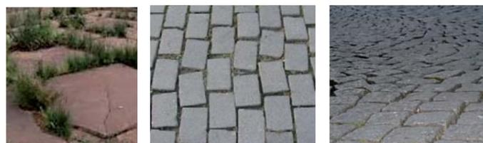
Les pavés non scellés engendrent un mouvement continu de la chaussée.
